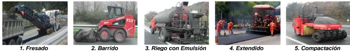
Figura 6. Puesta en Obra de la Mezcla Asfáltica
