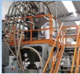
1.1 Dosaggio materie prime ed ingresso nella tramoggia
