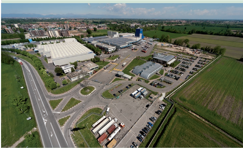
Figura 4: Impianto di Mediglia
