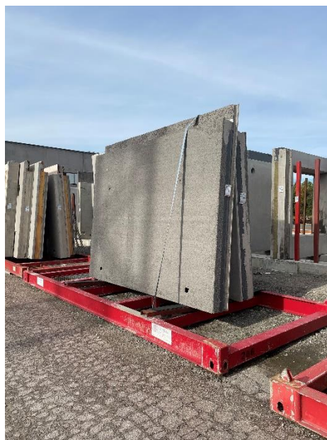
Figur 1 Sandwichvägg typ D (vänster bild) och typ CP (höger bild)
