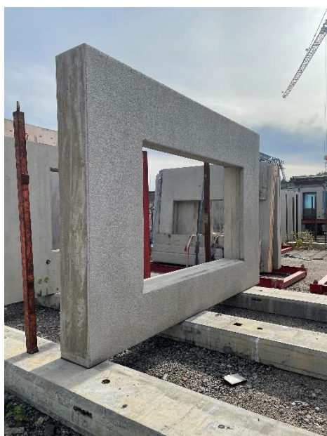
Figur 1 Sandwichvägg typ D (vänster bild) och typ CP (höger bild)
