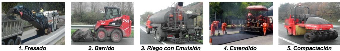
Figura 4. Puesta en Obra de la Mezcla Asfáltica
